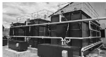
ガスを生み出す発酵槽
