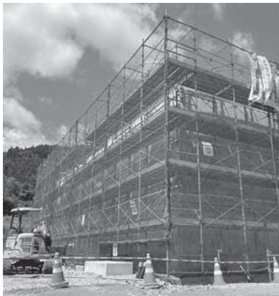
建設中の液肥タンク棟
